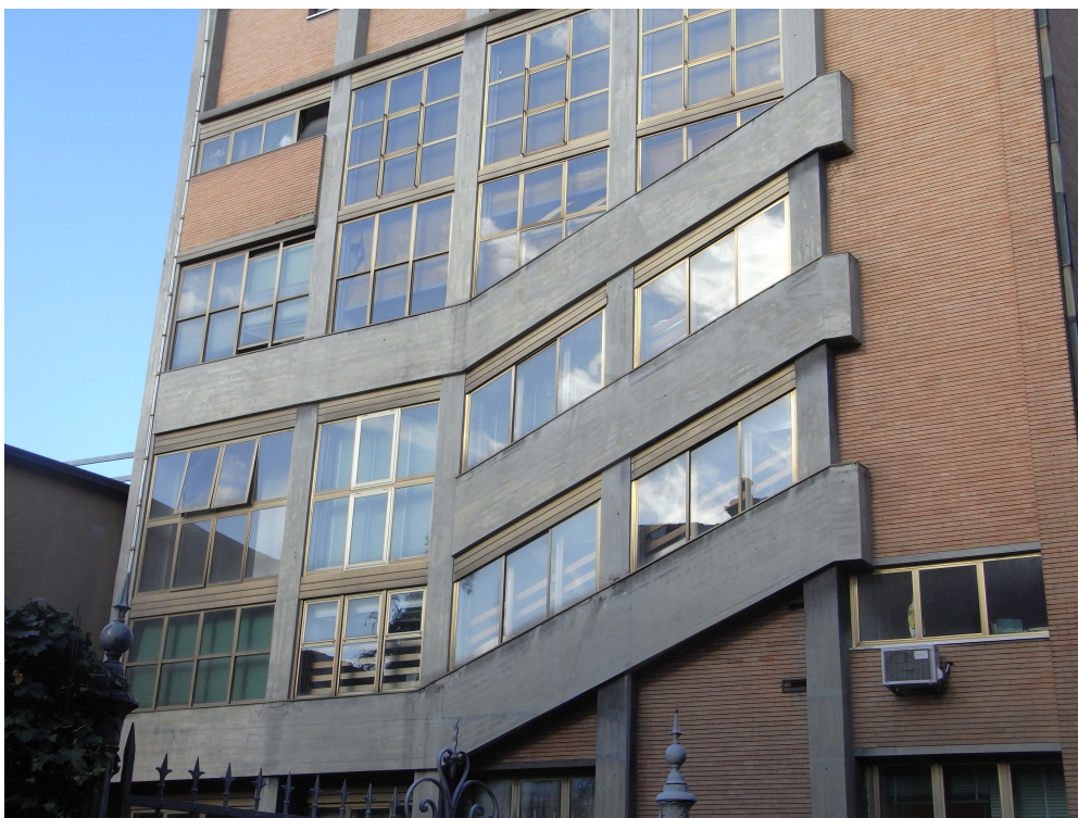
Foto 11, particolare delle finestre delle aule Pincherle e Cremona con doppio volume
